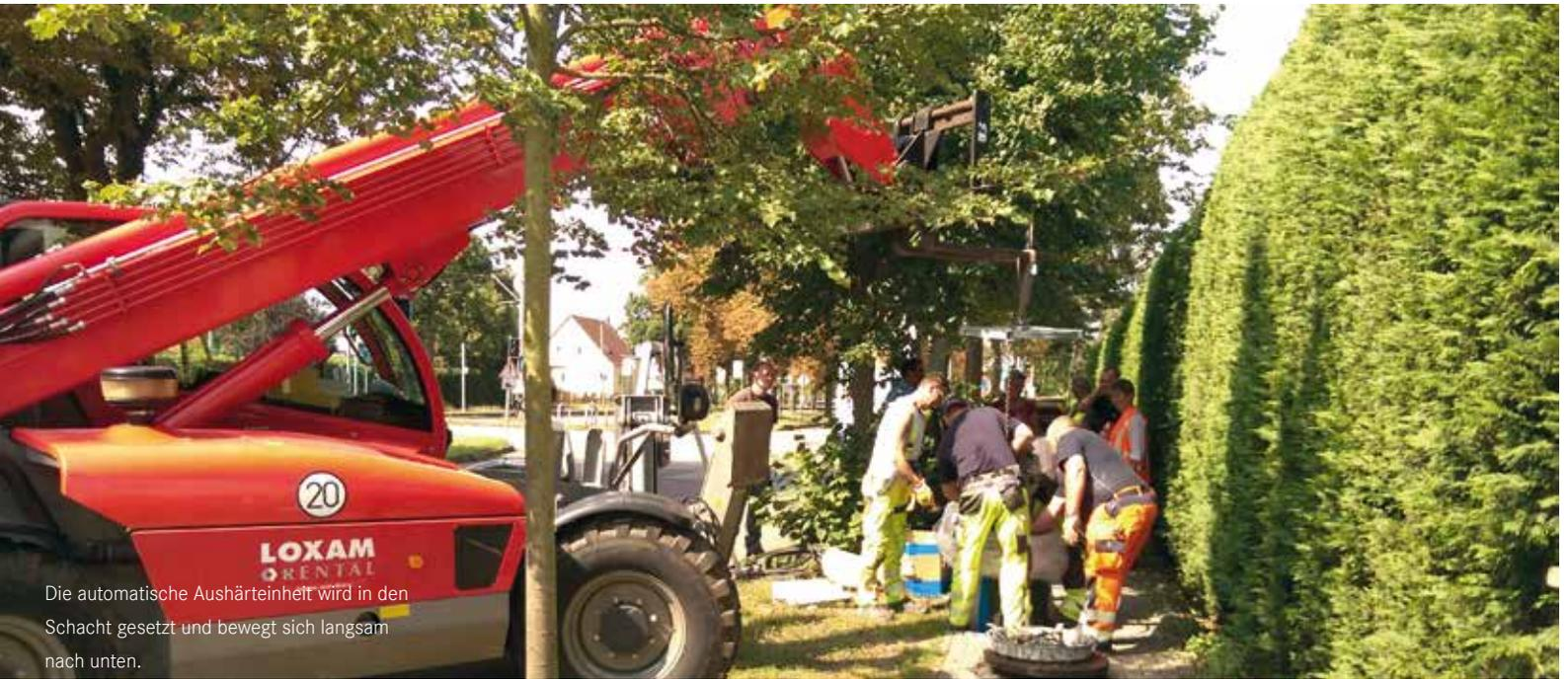
Die automatische Aushärteinheit wird in den Schacht gesetzt und bewegt sich langsam nach unten.
